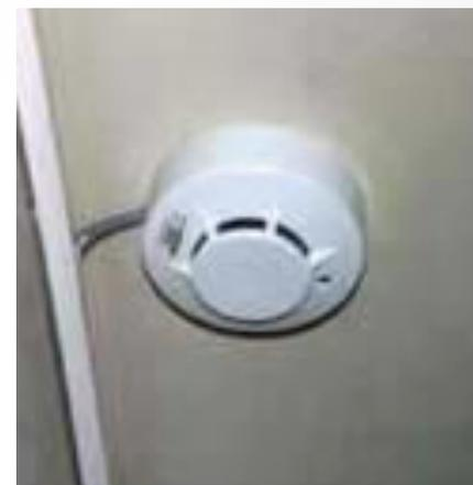
アメリシウム-241が使われている。アメリシウムから放射される $\alpha$ 線の電離作用によって、小さな隙間に電離電流が流れている。ここに煙が入ってくると流れる電流が小さくなるので、火災による煙を検知することができる
