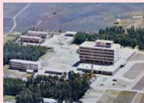
開院当時の北からの航空写真 田畑の中に松林に囲まれた病院、職員・看護師宿舎が見られます
