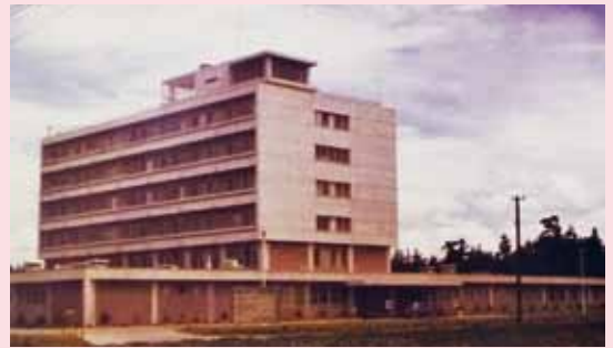
開院当時の西側からの外観 建設省の昭和38年度全国建設設計コンクールにおいて、第1位最優秀作品に選ばれました
