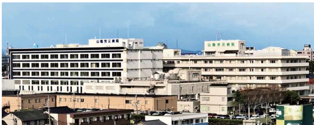
南からの新棟(左)と既存棟(右)の遠景
